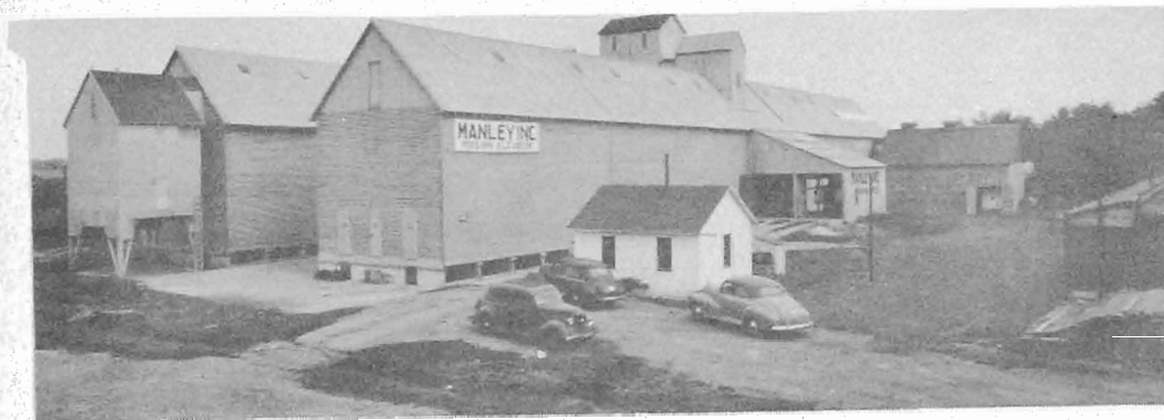
MANLEY ELEVATOR NO. 5—TARKIO, MO.
